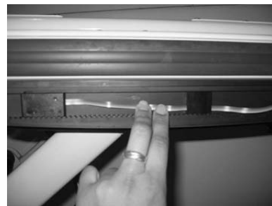
Figure 4d - Fixation des câbles
