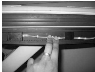
Abbildung 4d - Befestigen der Kabel
