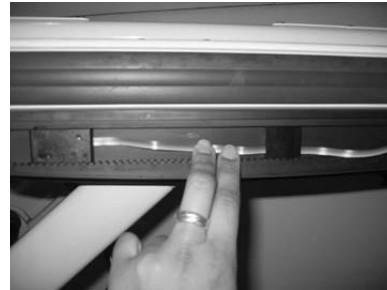
Figura 4d - Fissare i cavi
