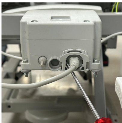
Slika 9 – Guranje blokade kabela za napajanje
