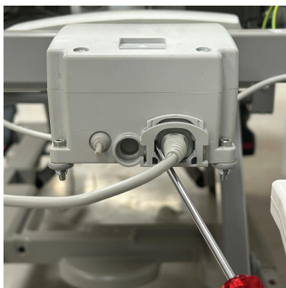
Slika 9 – Guranje blokade kabela za napajanje
