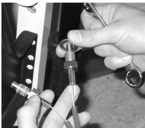
Kuva 66 - Aseta aluslevy uuteen vaijeriin
