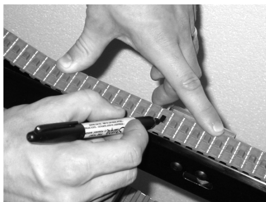
Figura 57 - Marque un diente de la guía para utilizarlo de referencia
