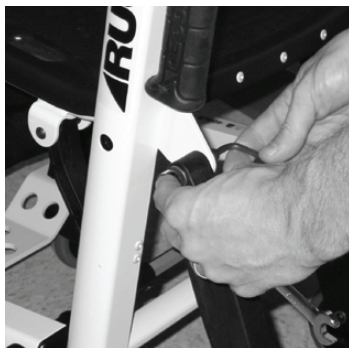
Figure 4 – Retirer la vis, l'écrou et la rondelle
