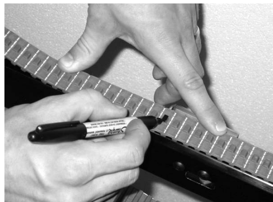
Figura 44 - Marque un diente de la guía para utilizarlo de referencia
