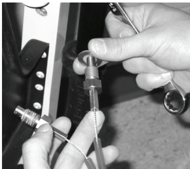
Figure 11 – Placer la rondelle sur le nouveau câble
