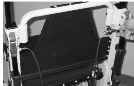
Figure 12 – Fixer un côté du nouveau câble
