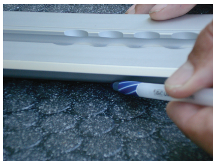
Figura 1 – Trace la placa de suelo
