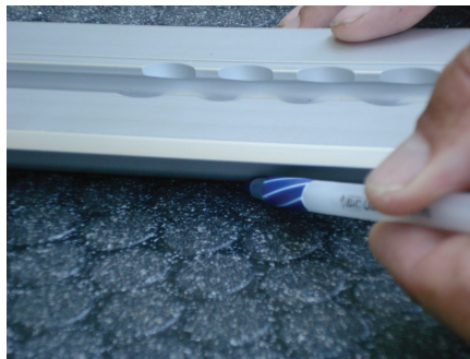
pav. 1 – Grindinės plokštės padėties žymėjimas
